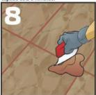
Remueva el exceso de BoquiCREST Ultramax de la superficie moviendo la llana diagonalmente a las juntas, cuando la mezcla este todavía
