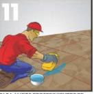
PARA AMBOS PROCEDIMIENTOS DE APLICACIÓN Con un trapo limpio o esponja húmeda, limpiela superficie de las losetas en forma diagonal al sentido de la junta, enjuagando periódicamente el trapo o esponia en aqua limpia.
