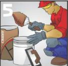
Vuelva a mezclar sin agregar agua y BoquiCREST Ultramax a estará listo para ser aplicado. Si el material llega a tornarse rígido antes de usarlo todo (aproximadamente 1 hora), mezcle nuevamente, sin agregar agua.
