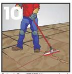
Extienda BoquiCREST Ultramax sobre el área con un jalador (tipo limpiador de vidrios de hule) con movimientos diagonales a la junta, asegúrese que el BoquiCREST Ultramax penetre hasta el fondo de la junta y nivele al borde de la loseta.
