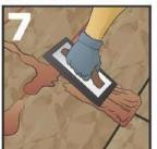
Con una llana de esponja dura, distribuya el BoquiCREST Ultramax en forma diagonal, presionando para que la mezcla penetre en los espacios o juntas, cuidando que quede bien compacta y libre de espacios vacíos, hendiduras o fisuras.
